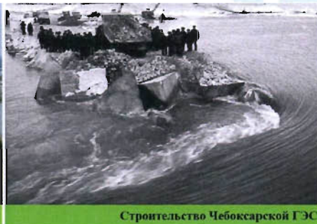
Строительство Чебоксарской ГЭС
